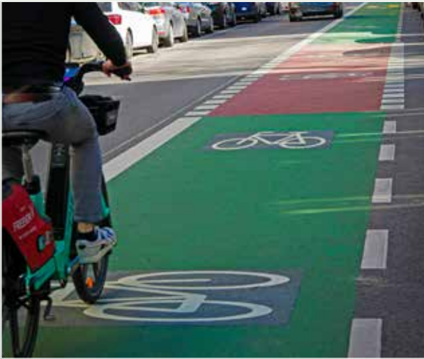
Für mehr Sicherheit – Berlin Neukölln & Treptow-Köpenick mehrere 10.000 m 2 grüne Radwege – im Gefahrenbereich wird der Radweg rot ausgeführt
