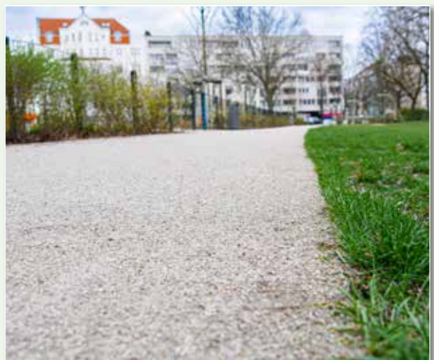
Gestaltung von Parkflächen – Olivaer Platz in Berlin vdw 700 mit 1–3 mm Granitsplitt erzeugen die Optik einer Wassergebundenen Wegedecke bei deutlich geringerem Pflegeaufwand
