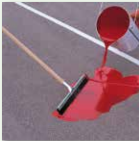
Material vollständig ausgießen und mit Gummischieber verteilen
