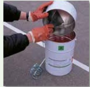
Komponente B in Komponente A einfüllen und gründlich durchmischen
