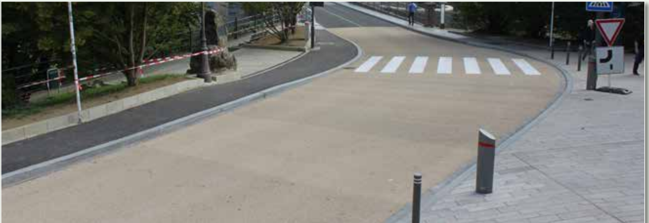
Urbane Designlösungen – Zürich (Schweiz) vdw 700 transparent mit Granitsplitt ersetzen Farbasphalt
